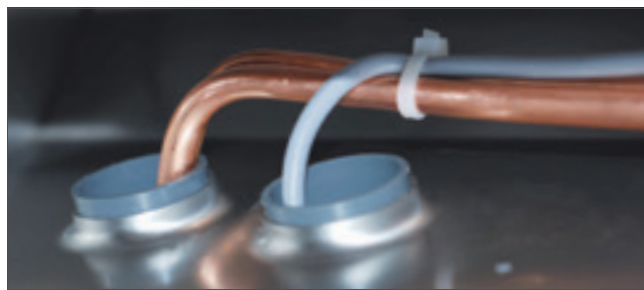
hochgezogene Schutzkragen für Kabel und Kälteleitungen
