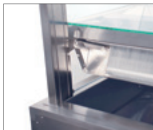
leichte Reinigung des beschichteten Umluftverdampfers mittels Hebelift
